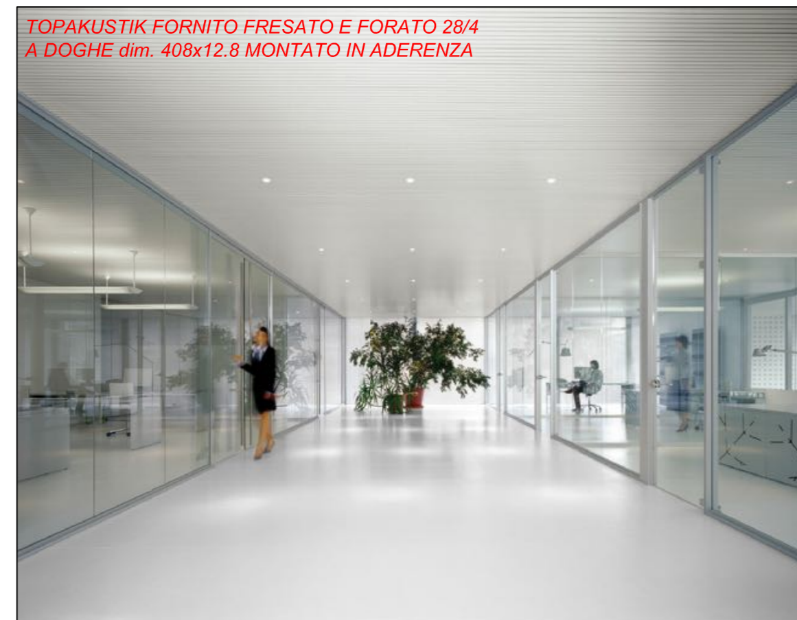
TOPAKUSTIK FORNITO FRESATO E FORATO 28/4 A DOGHE dim. 408x12.8 MONTATO IN ADERENZA
